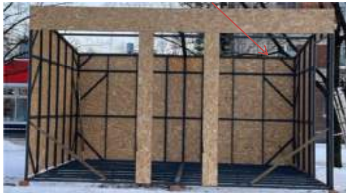
Сварной металлический каркас
